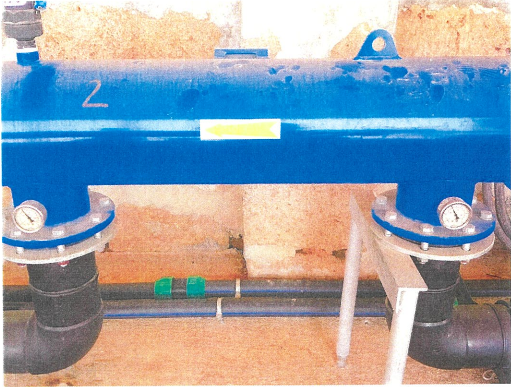
Şekil 2. Filtre Giriş-Çıkış Basınç Göstergeleri
