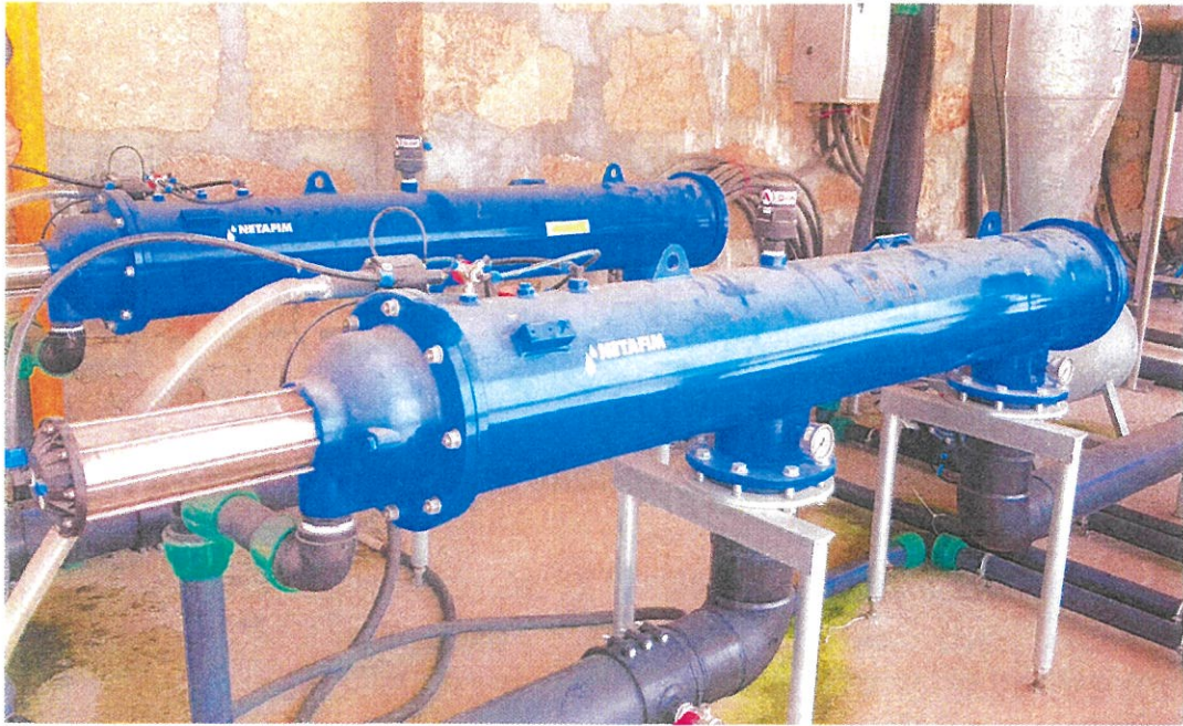
Şekil 1. Tam Otomatik Kendini Temizleyebilen Filtre Ünitesi
