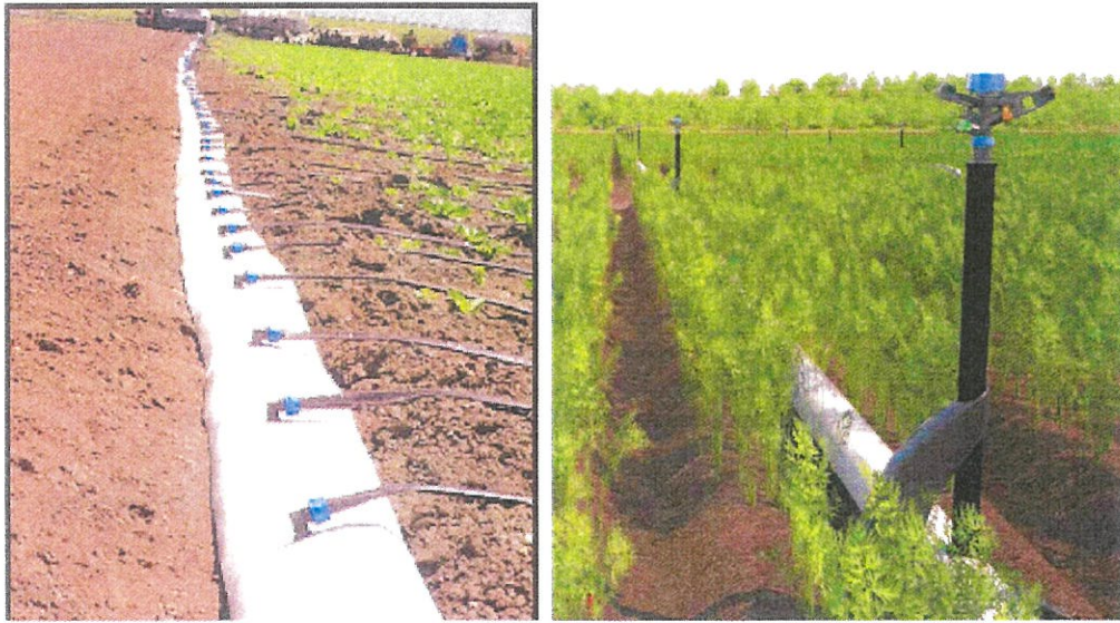
Şekil 1. Flexnet boruların arazide kullanımı
